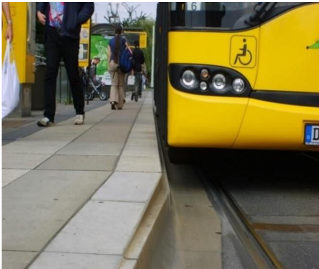
Rys. 7.2 Wyrównanie wysokości krawędzi peronowej z pierwszymi drzwiami autobusu.
